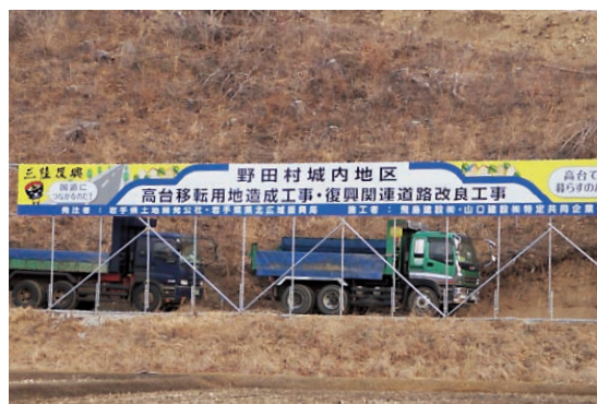
2014年1月25日野田村十府ヶ浦海岸と高台移転造成工事
